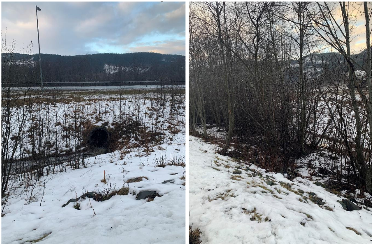
Figur 2-3 Øyabekken ved kulverten under dagens E6 (Kilde: Norconsult)
