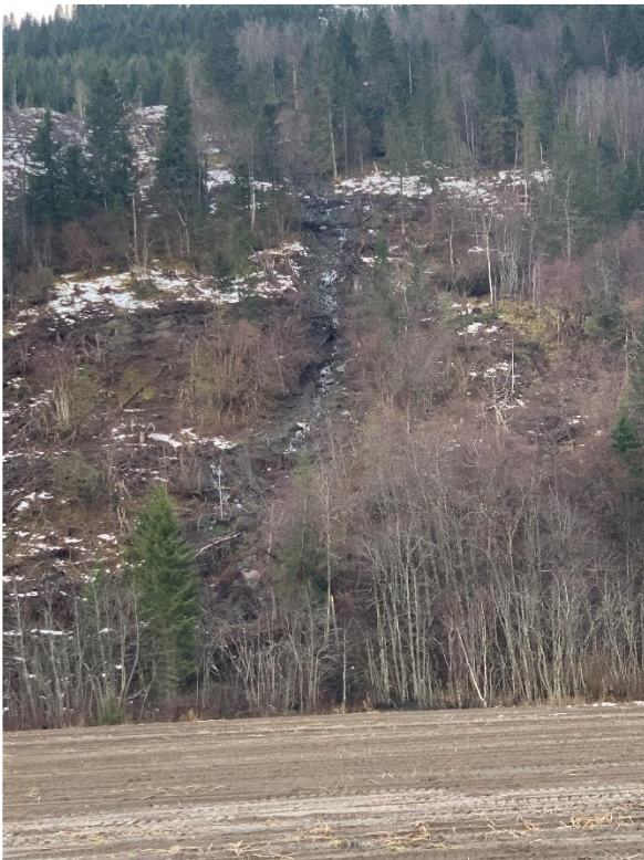
Figur 2-16 Liten bekk mellom Grinnibekken og Floksa, nedover skråningen (kilde: Norconsult)
